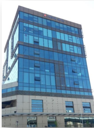
Orta Anadolu Kalkınma Ajansı Merkez Hizmet Binası – Kayseri
